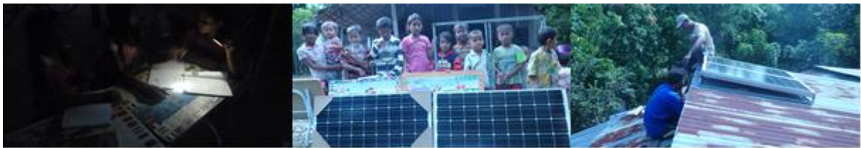
v.l.n.r.: studeren in het donker met zaklampen, de zonnepanelen, installatie van de zonnepanelen
