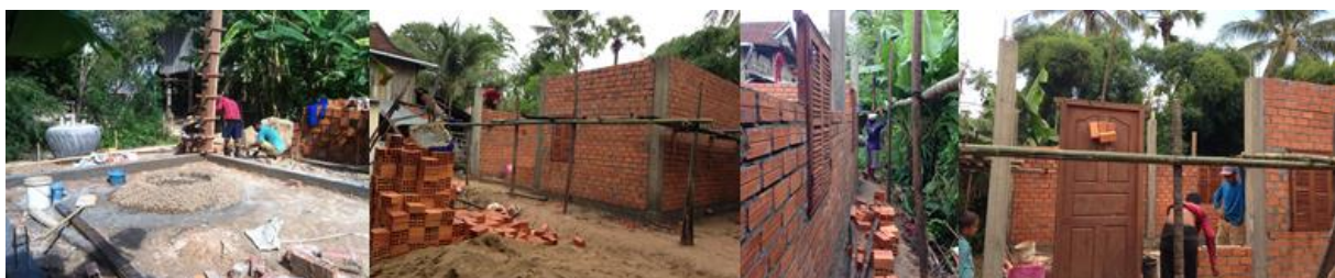
fundatielegging en bouw
