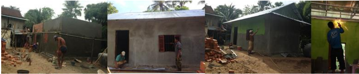
bouw van het lokaal
